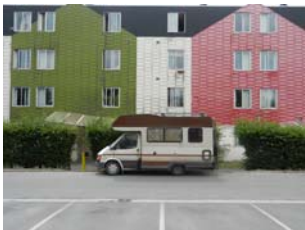
Existant : Hall d'entrée
